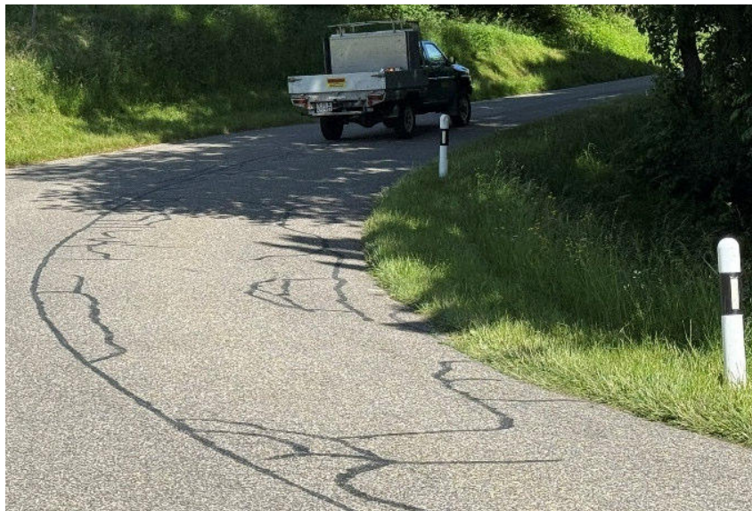
Abbildung 1: Absenkung Strasse in der Kurve Vogelbach
