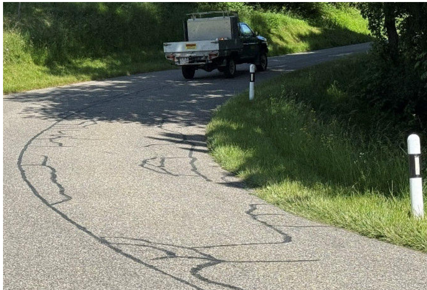
Abbildung 1: Absenkung Strasse in der Kurve Vogelbach
