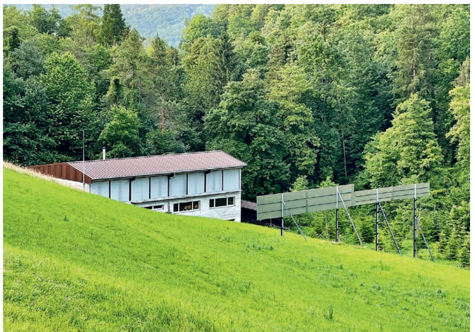
Die Regionalschiessanlage Chrüzlibachtal Rekingen von oben her gesehen
