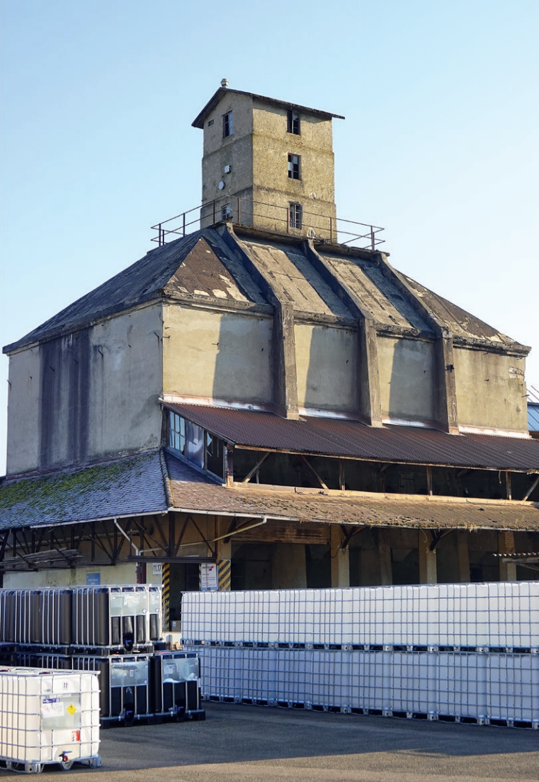
Faszinierende Industriegeschichte: Der Silo für die Lagerung von Soda im Originalzustand (Baujahr 1915)...
