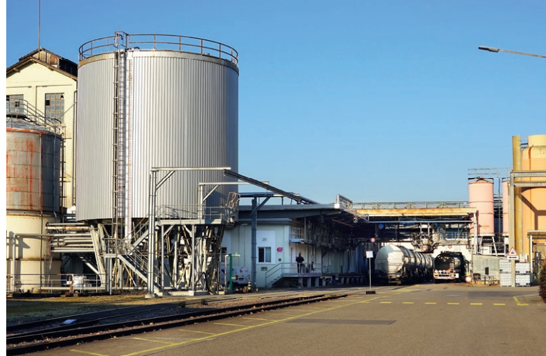
Anlieferungsbereich der Lobeck Chemie AG (Bahn und Strasse)
