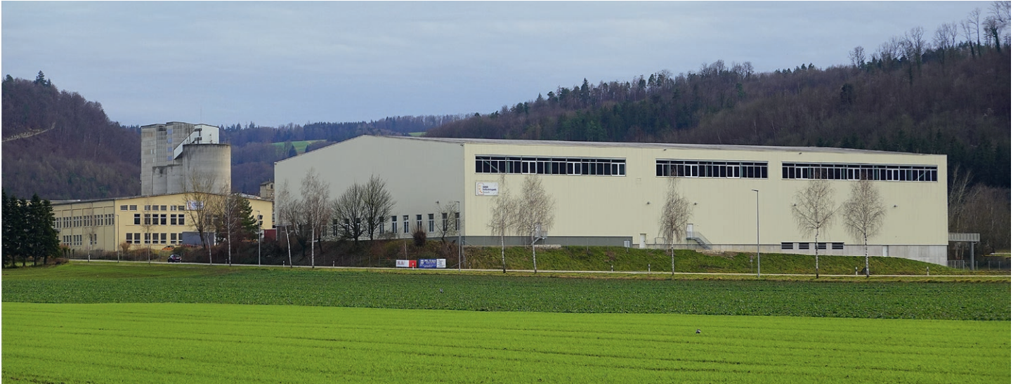
Die riesige Halle eingangs Rekingen ist nicht zu übersehen. Links davon das renovierte ehemalige Gebäude der Chlor-Alkali-Elektrolyse, in dem heute die Firma Comadur S.A. ihre Produkte herstellt
